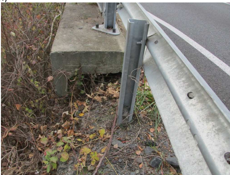
42) Ukotvení svodidel mezi římsovými prefabrikáty
